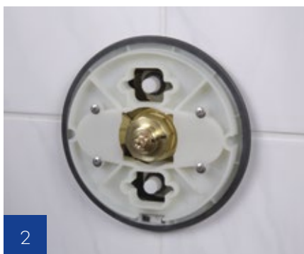
2 Montageplatte installieren
