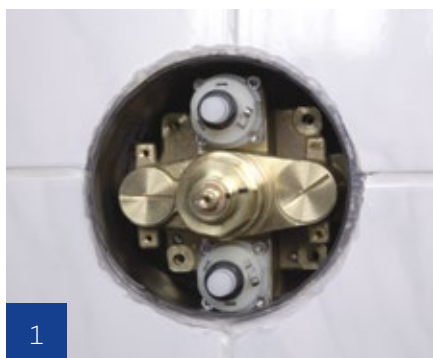
1 Funktionseinheit in die KLUDI FLEXX.BOXX montieren
