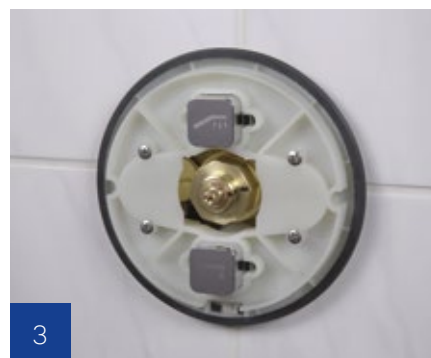
3 Druckknöpfe installieren
